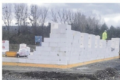
Feuerwehrhausneubau Schwebda: es geht voran! Rund zwei Millionen wird er kosten. FOTOS: GEMEINDE MEINHARD/INH
