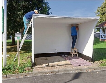
Erhielt frischen Anstrich: Das Bushäuschen an der Julius-Schmincke-Straße.
