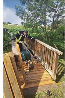
Neu beplankt: die Brücken über den Mühlbach.
