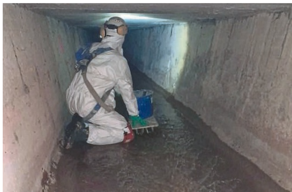
Auf Knien muss bei der Reparatur der Unterbewehrung des Mühlbachs in Jestädt gearbeitet werden. Der Stahl liegt zum Teil frei. FOTO: PRIVAT
