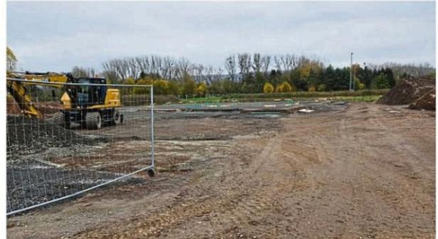
Rohbau soll bis Weihnachten stehen: die Bodenplatte für den Feuerwehrneubau Schwebda sowie Kanäle sind bereits gelegt.
