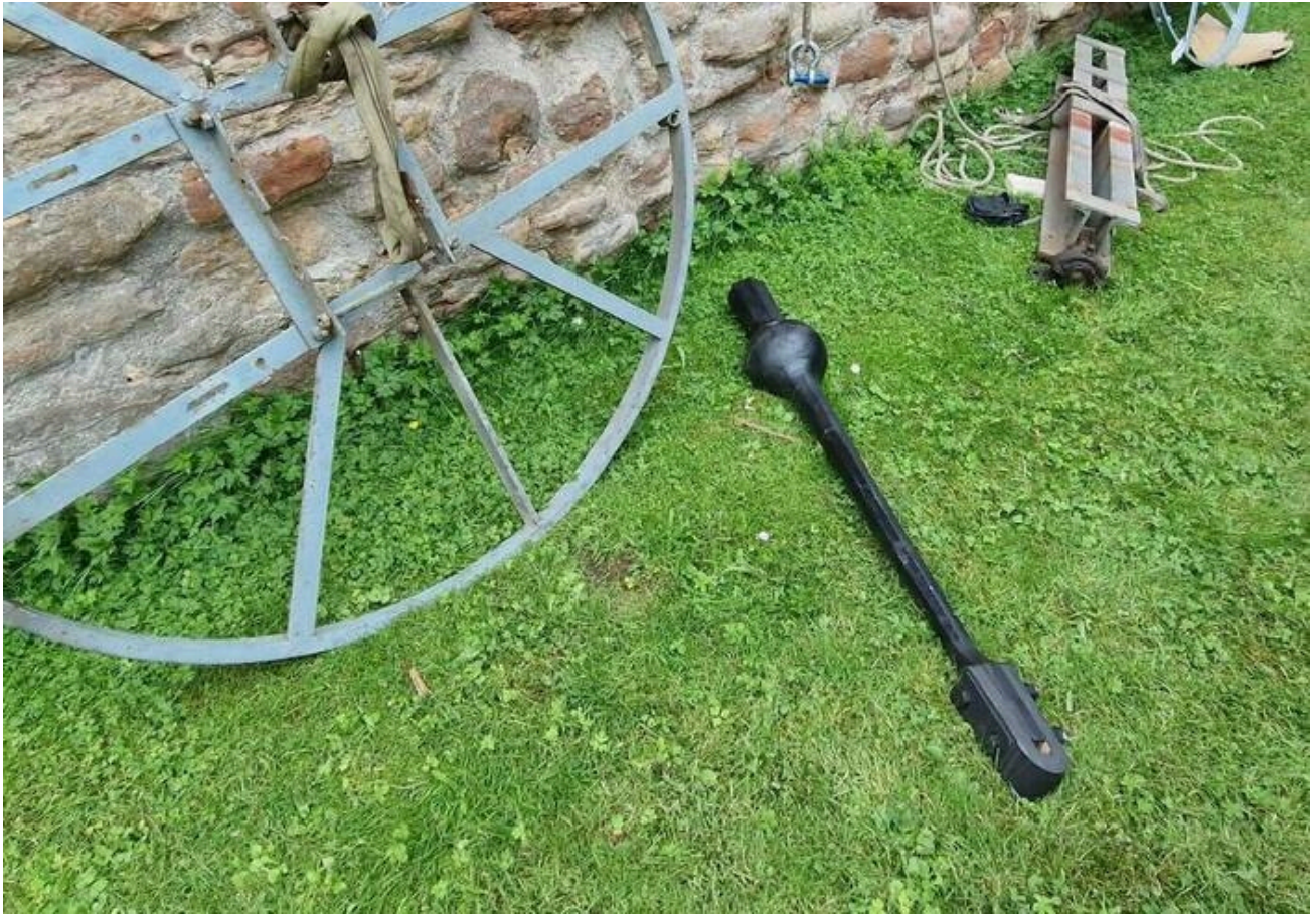
Das alte Antriebsrad wird durch ein neues ersetzt und der alte Klöppel wartet auf seinen Einbau.
