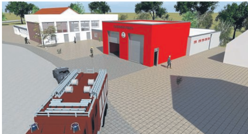
Eingeschossig und feuerrot: Das neue Feuerwehrgerätehaus in Frieda neben der Weinberghalle. Die Hülle des eingeschossigen Baus soll noch dieses Jahr fertig werden. FOTO: ARCHIV
