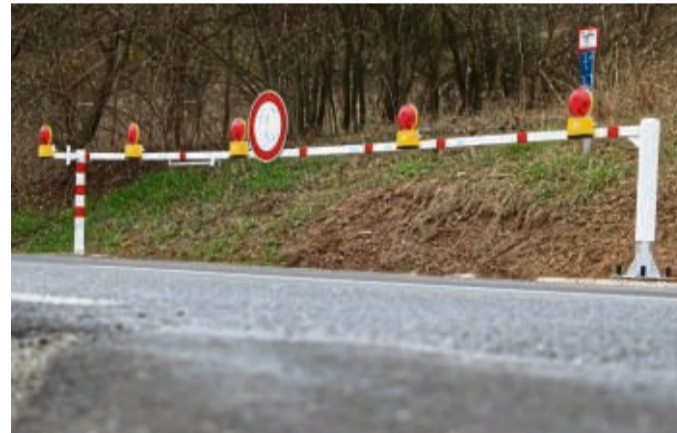
Neuanschaffung: So sehen die Schrankenanlagen zwischen Jestädt und Grebendorf aus. Derzeit sind sie aber noch nicht in Betrieb.
