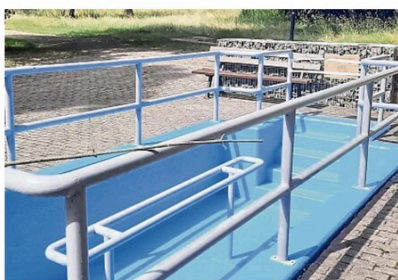
Erstrahlt in kräftigem Blau: die frisch gestrichene Wassertretanlage in Hitzlerode.
