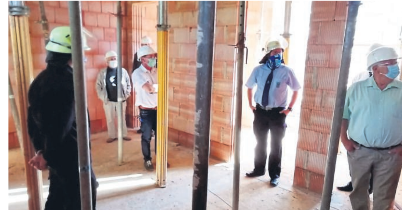
Rohbaubesichtigung: Mitglieder des Gemeindevorstandes Meinhard und der Feuerwehr Frieda bei einer Besichtigung der Baustelle des neuen Feuerwehrgerätehauses an der Leipziger Straße in Frieda.
