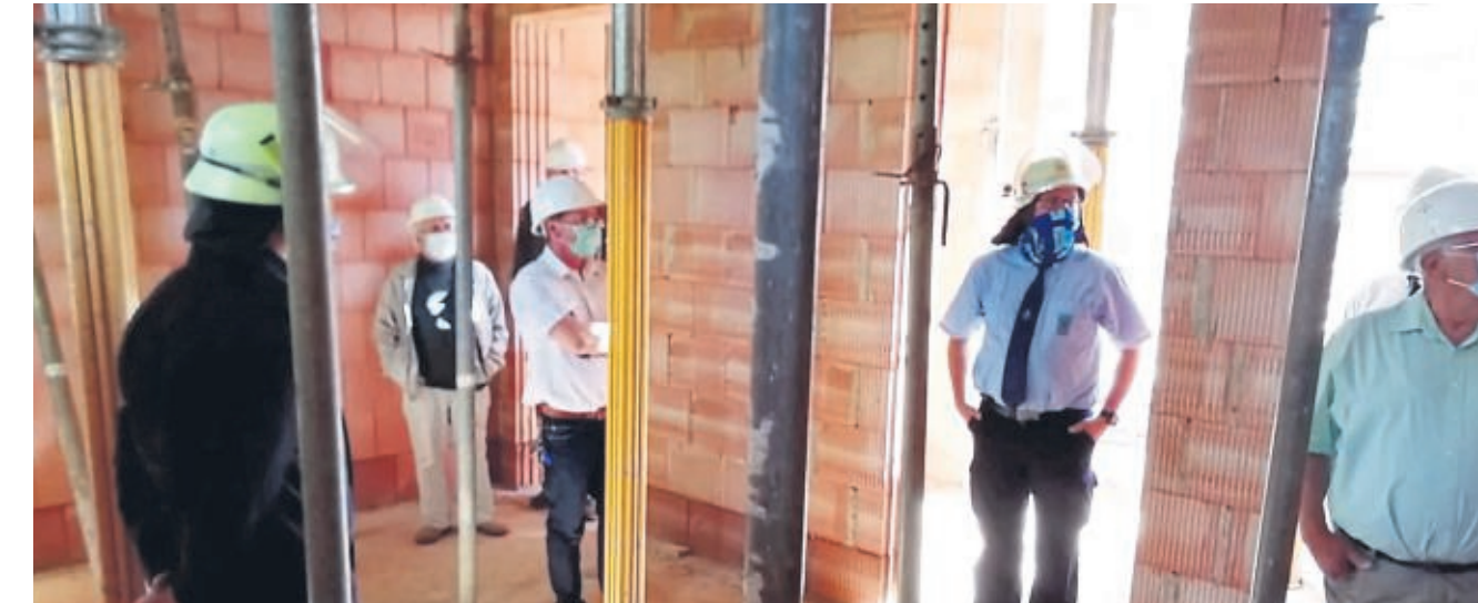
Feuerwehr im Werden: Das neue Gerätehaus der Freiwilligen Feuerwehr im Meinharder Ortsteil Frieda befindet sich noch im Rohbau – hier bei einer Besichtigung der Baustelle durch den Gemeindevorstand.
