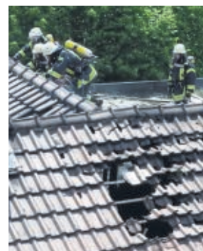
Einsatz der Retter auf dem Dach.
