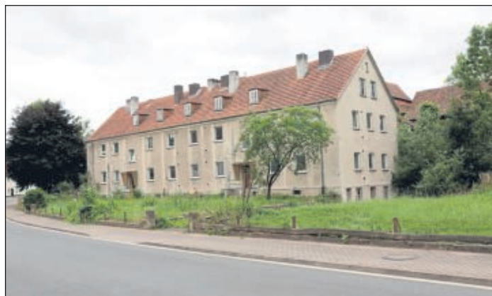
Nicht geeignet: Das Gelände des Zollhauses in Frieda ist laut Bürgermeister Brill ungeeignet für das neue Gerätehaus.
